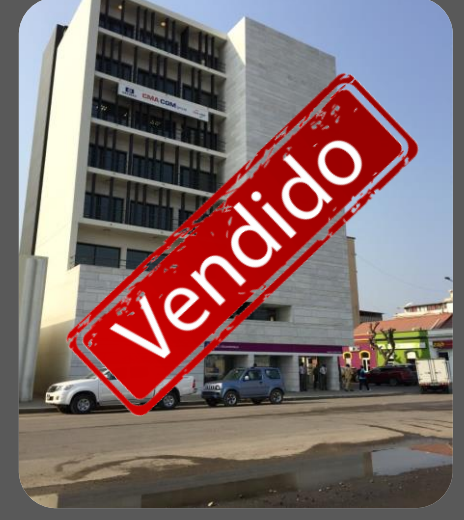
Edifício Lobito Colina
