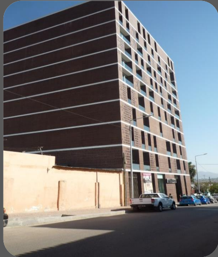
Edifício Lubango Center
