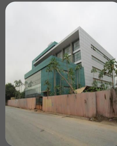
Edifício Data Center
