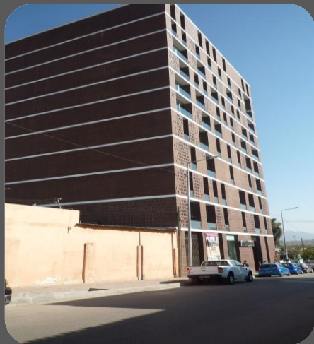
Edifício Lubango Center
